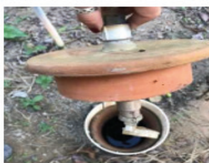
1.b Boia que controla a entrada e saída da água.
